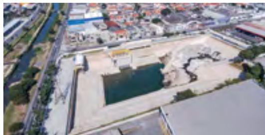
**Piscinão Aricanduva - SP.** Parte do projeto de controle das enchentes na Bacia do Rio Aricanduva, zona Leste de São Paulo, armazena até 150.000 m<sup>3</sup> e conta com estruturas de controle de vazão, vertedor de entrada e casa de bombas com 7 bombas submersíveis. A obra incluiu a readequação das Estruturas de Extravasão nos reservatórios AR-1, AR-2, AR-3 e Limoeiro, e a canalização e readequação das margens de córrego.
