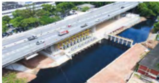
**EBAP Marinho - ES.** Estação de Bombeamento de Águas Pluviais com vazão de 20 m<sup>3</sup>/s, na margem do Rio Marinho, fará o escoamento das águas do Córrego Campo Grande, Jardim de Alah e Bacia do Aribiri. Conta com 8 bombas submersíveis, 6 comportas de canal, 10 comportas na entrada do poço de bombas, 8 gradeamentos mecanizados, 1 monovia e o eletrocentro, para automação de todo o processo.
