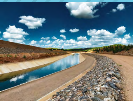
Canal que integra o sistema de infraestruturas do Ramal do Agreste (PE), supervisionado pela TPF Engenharia.
