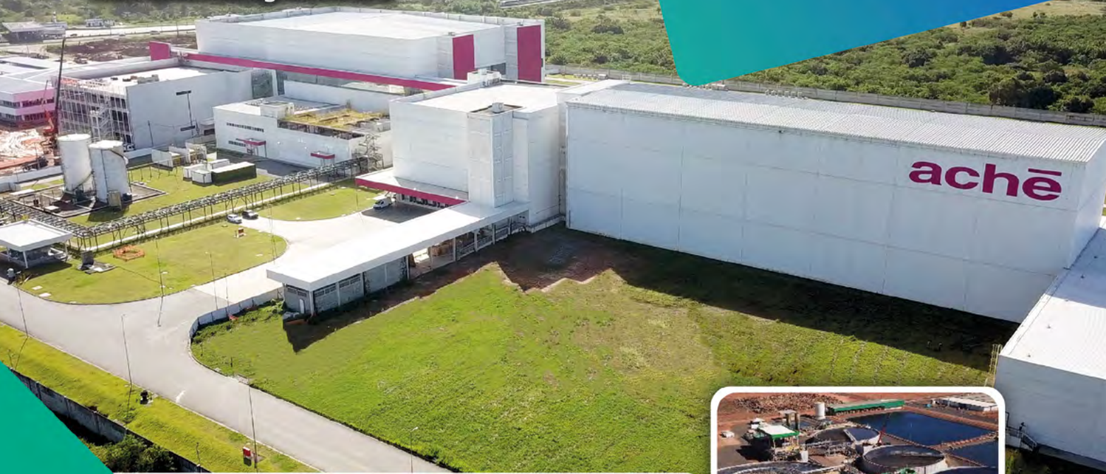
Nova fábrica Aché Laboratórios Cabo de Santo Agostinho/PE
