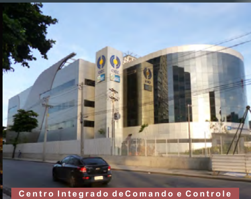
Centro Integrado de Comando e Controle
