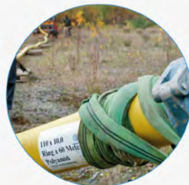
GASODUTO CEGÁS | Caucaia - CE
