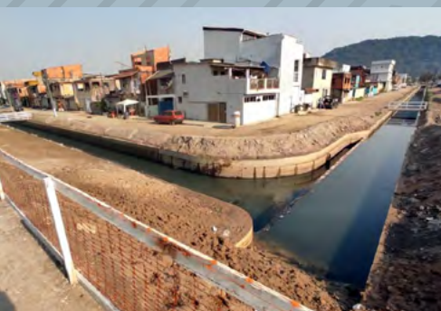
Canal da Francisco Arnaldo Gimenez e canal de ligação na Alameda José Nunes, pela empresa Terracom.
