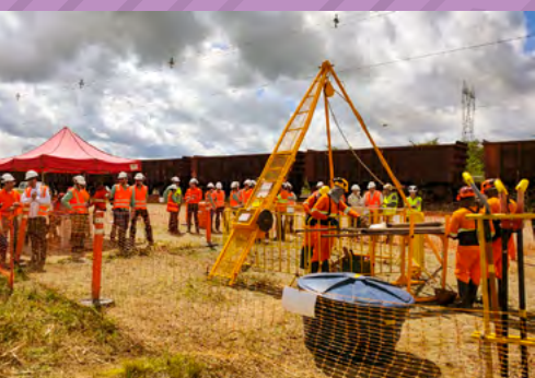
Praça de sondagem da Engefoto em Paraubebas/PA, durante a execução dos serviços de topografia e sondagens geotécnicas no Ramal Ferroviário Sudeste do Pará (RFSP) para a Vale.
