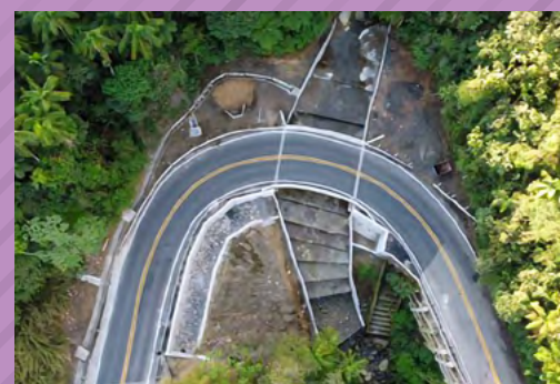
Obra de Infraestrutura para reestabelecimento do tráfego rodoviário na rodovia RJ 163 pela SEEL.
