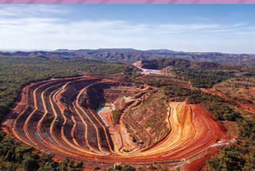
Obras de Recomposição de Cava, pela ATERPA em Vazante, MG
