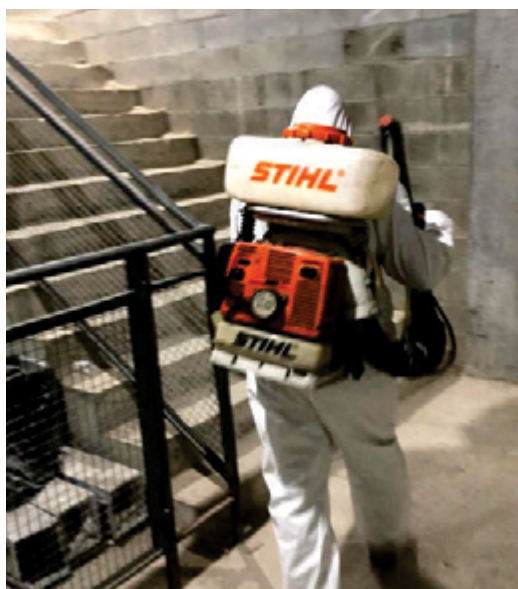
Sanitização de áreas comuns - obra Mozak
