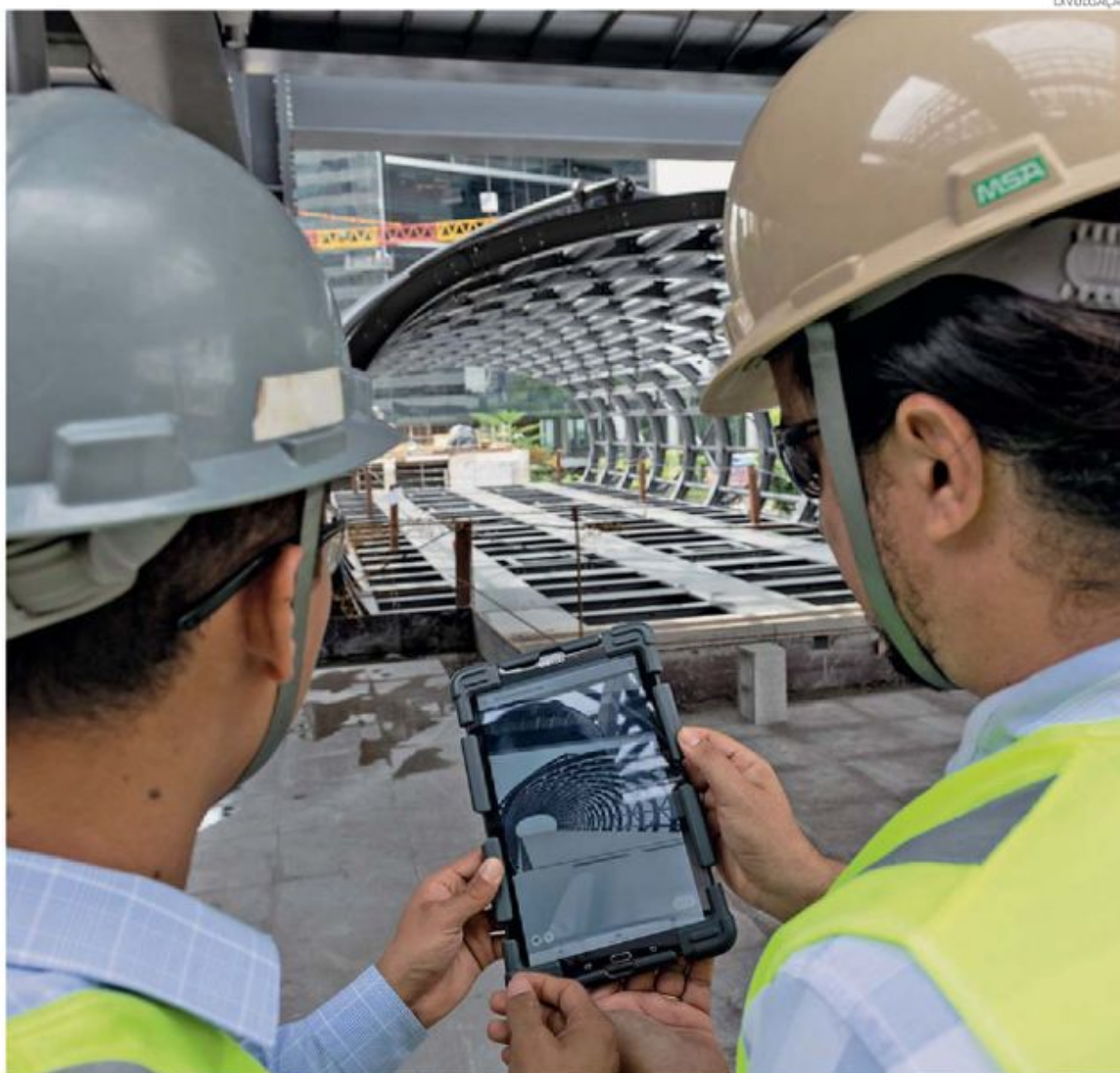
Uso de tablet para acompanhamento de obras em tempo real da Camargo Corrêa
